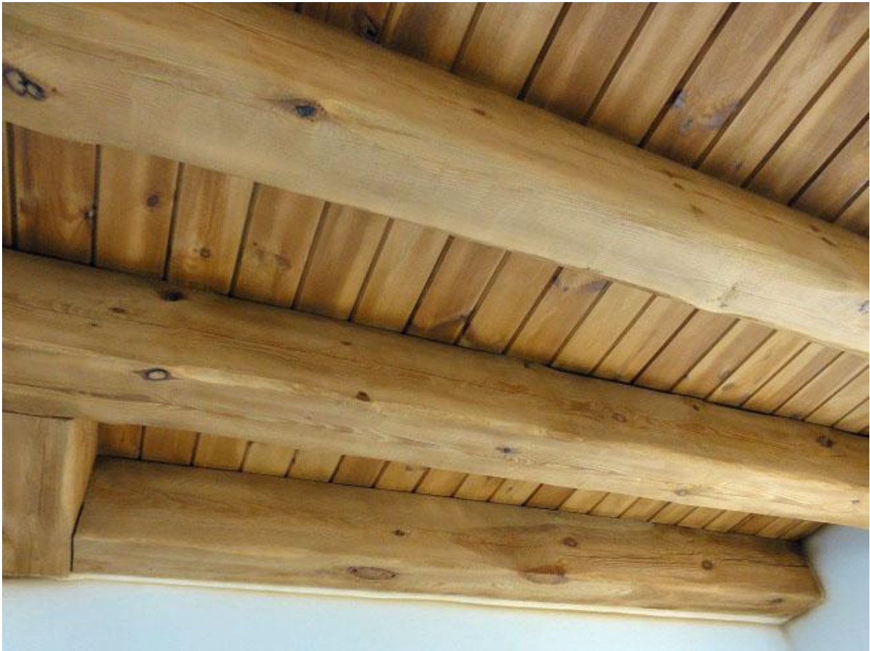
Fot. 8. Przykład modernizacji stropu z zastosowaniem nadbitki.
