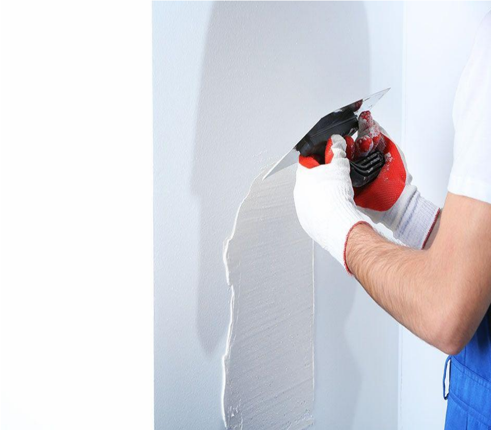
Fot. 14. Przykładowy sposób wykonania gładzi ściennych.
