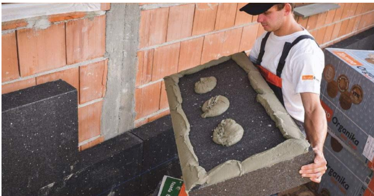
Fot. 17. Docieplenie przegród w systemie mokrym-lekkim styropianem grafitowym.
